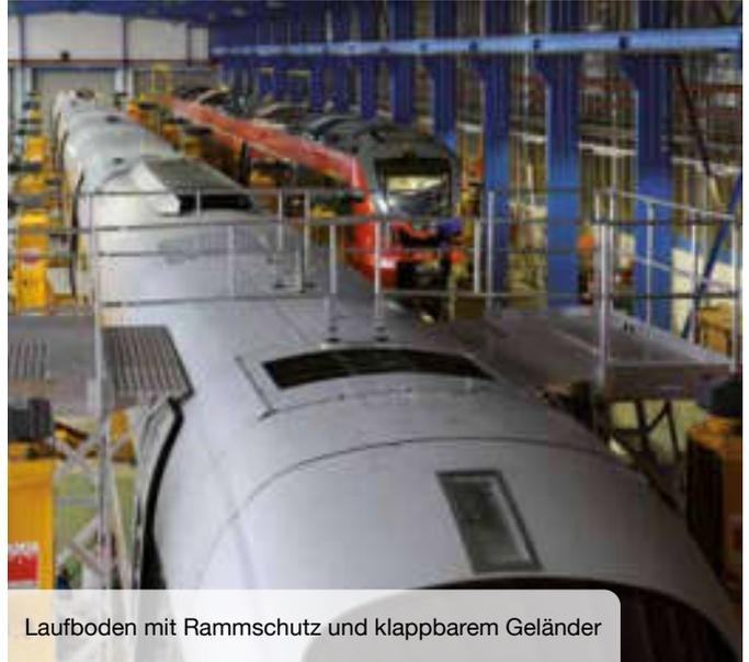
Laufboden mit Rammschutz und klappbarem Geländer
